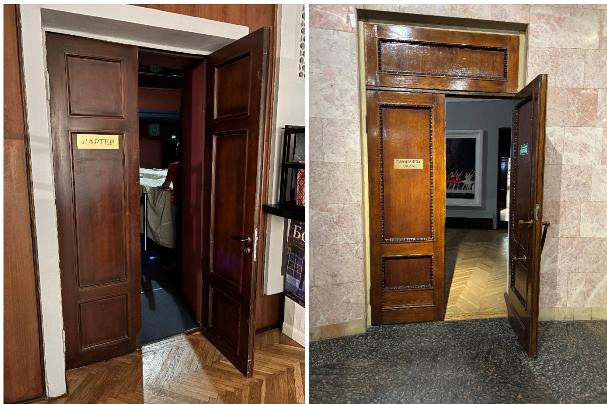
Фото 1.14-15 Загальний вигляд входів до приміщень
