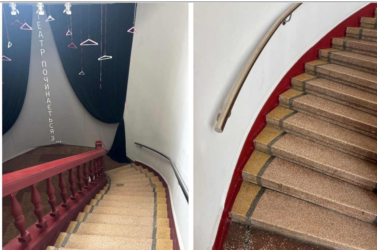
Фото 1.8-9 Загальний вигляд внутрішніх сходів
