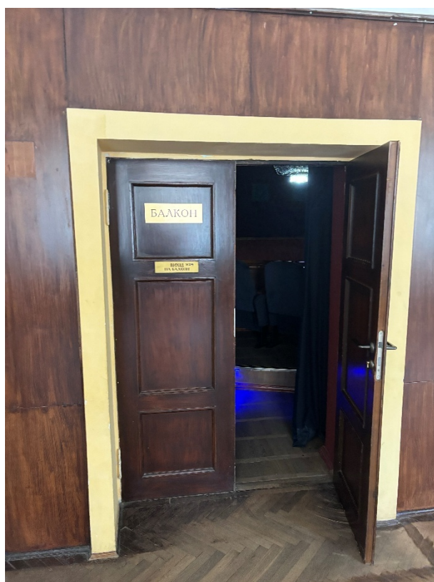
Фото 1.14-16 Загальний вигляд входів до приміщень
